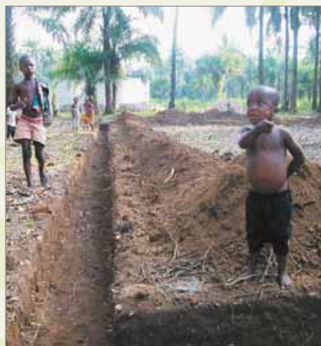
Fondamenta della mensa di Lokomasama
